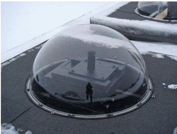
図5 (a) 設置した撮像部 ドームの外側からの様子 (中心の筒状のものが魚眼レンズ)
