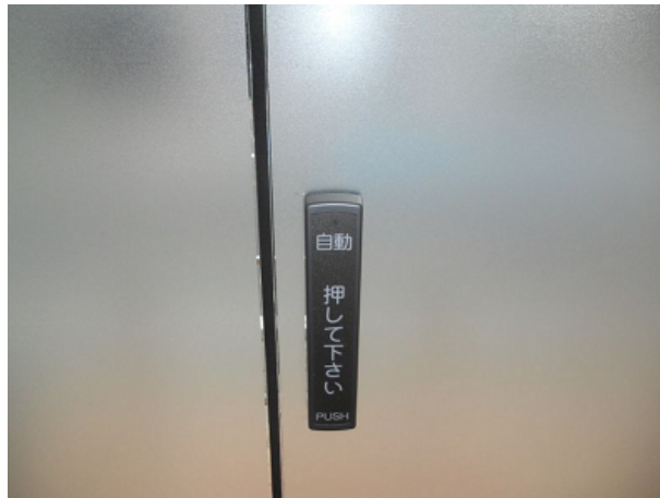
図 1.3: 自動ドアタッチ式センサ
