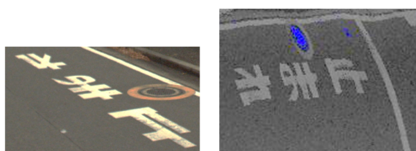
図 3-22 道路標示（止まれ）とマンホール蓋
