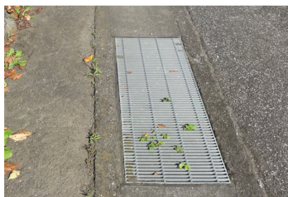
図 7-12 グレーチング蓋の画像
